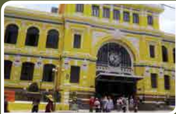
La poste centrale
